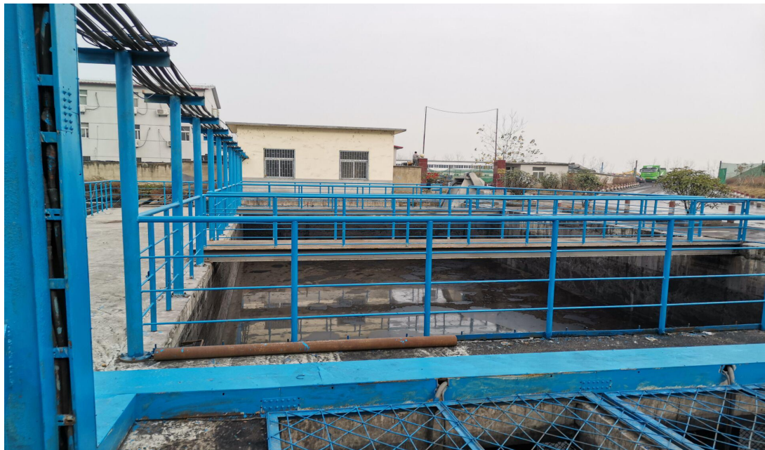
地面废水沉淀池
