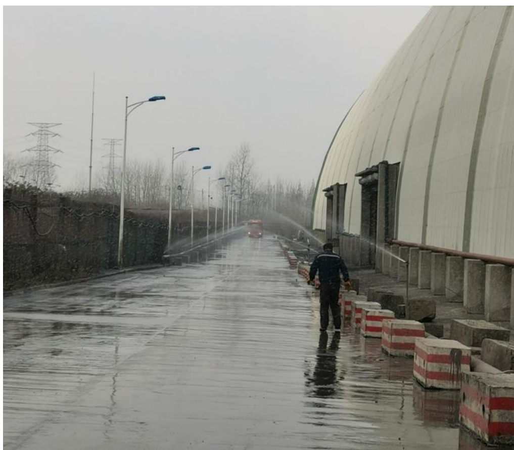
运输道路喷洒降尘
