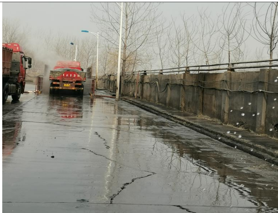
车辆冲洗水收集沟
