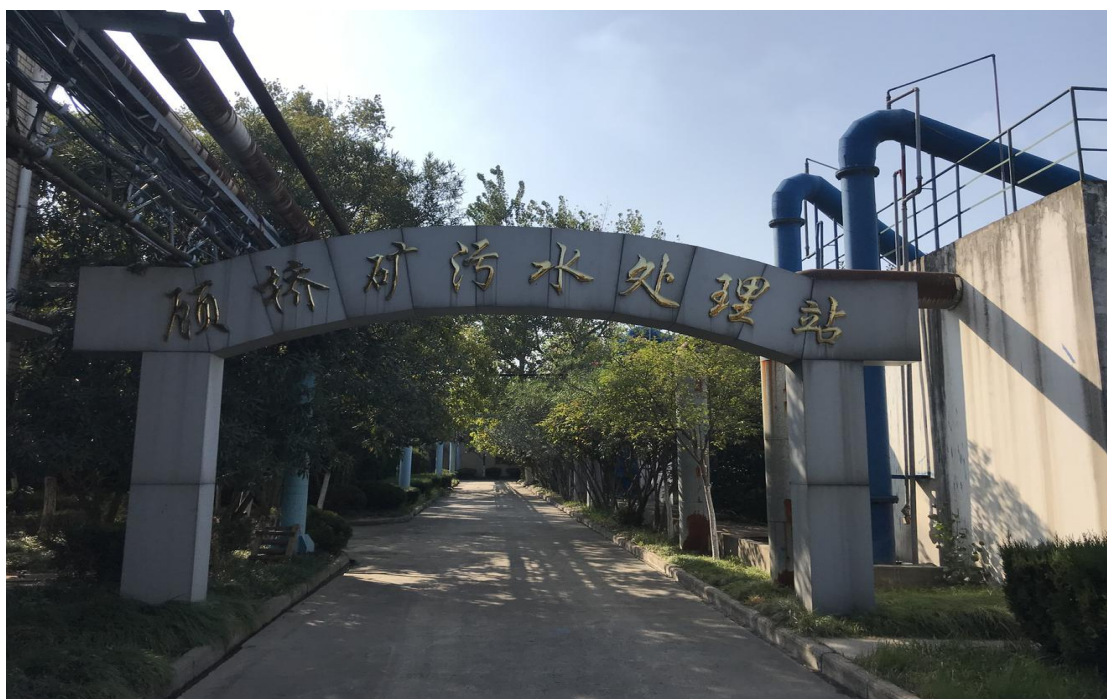
图 3-2 废水治理措施
