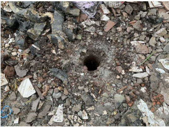
地下水监测井建井
