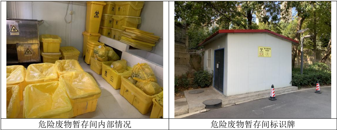
图 3-2 危险废物暂存间
