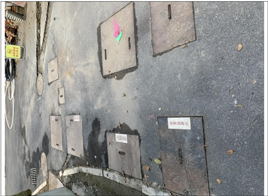
地埋式污水处理站加盖处理
