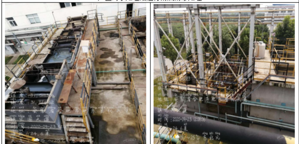
厂区污水处理站进行防腐防渗处理
