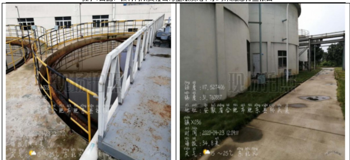
厂区污水处理站进行防腐防渗处理
