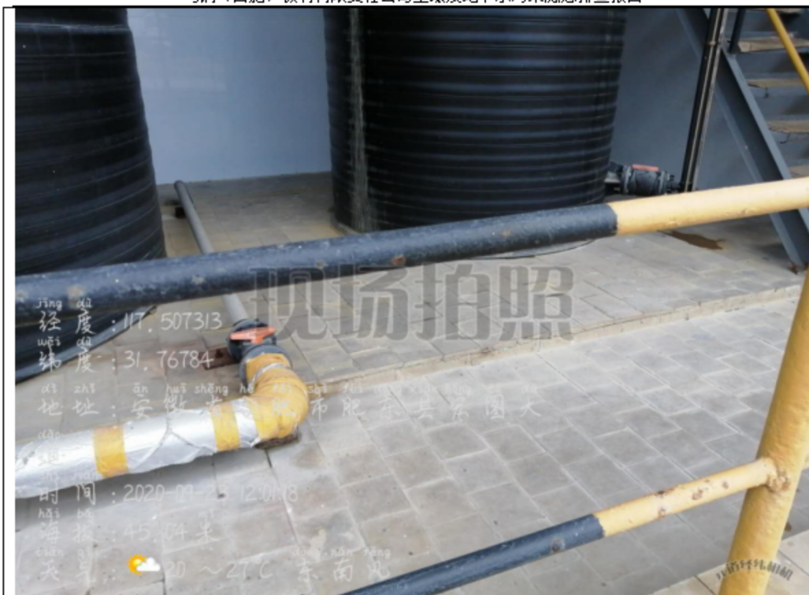
液体储罐区设置围堰并进行防腐防渗处理
