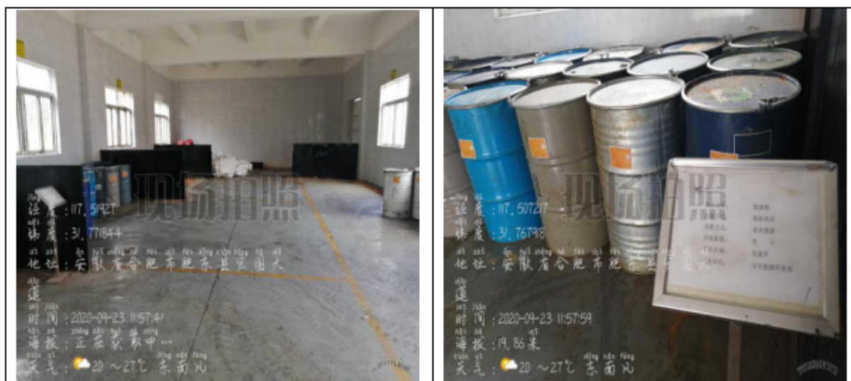
危废仓库进行防腐防渗处理
