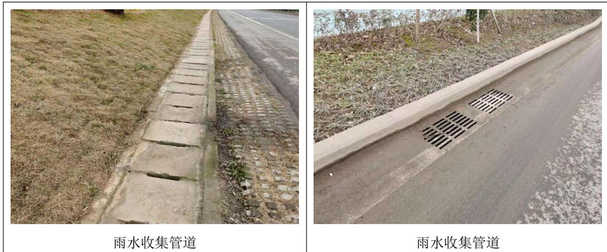
图 9-2 桥面径流收集及应急池
