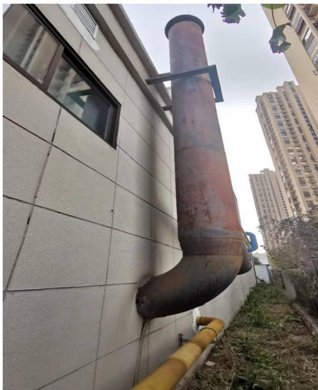
图 4.1-2 锅炉废气排气筒
