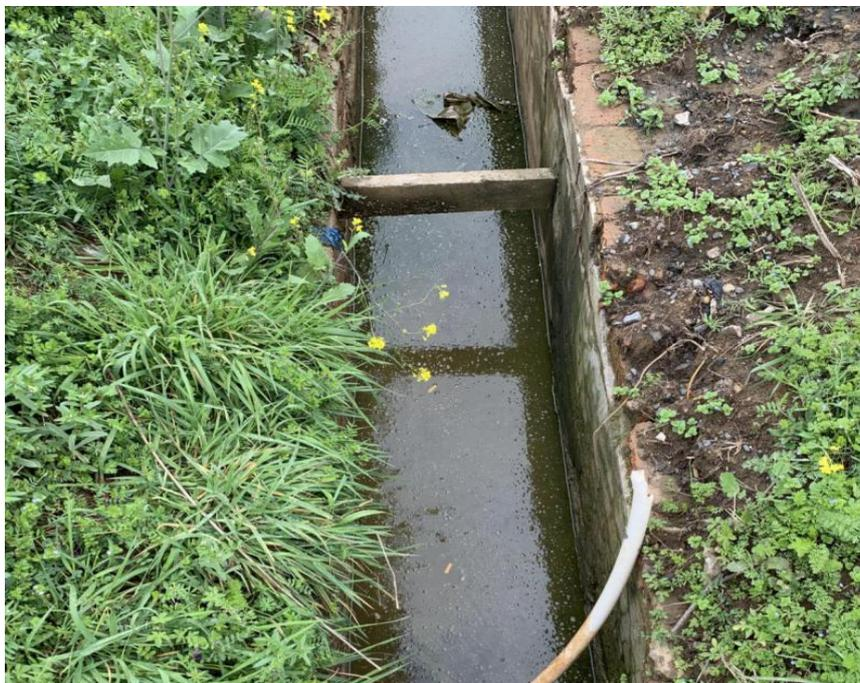
图 4.3-5 排水沟淤堵、破损
