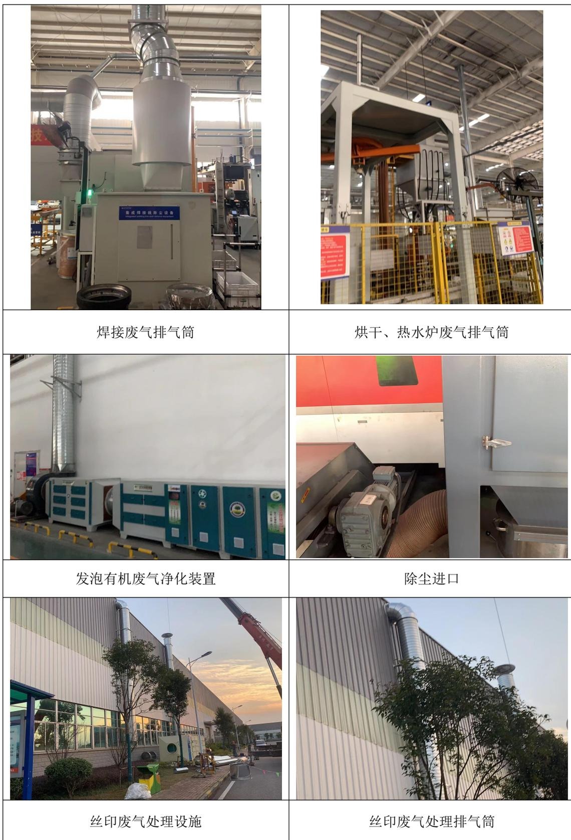
图 4-4 项目废气处理设施照片
