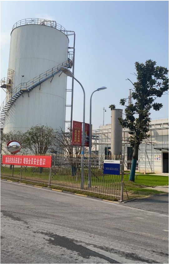
渗滤液处理站
