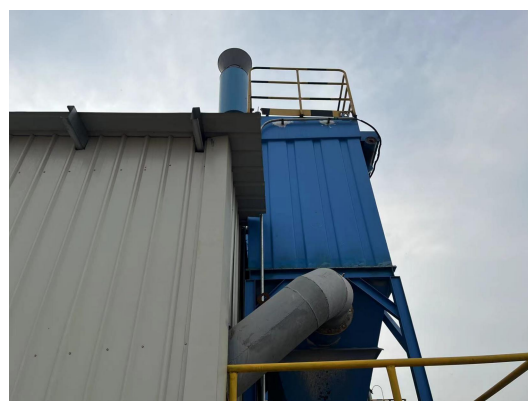
破碎粉尘、粗破筛分粉尘、提升机进料点粉尘、定量给料机进出料点粉尘、制砂机落料点粉尘布袋除尘器+28m 高排气筒 (DA002)
