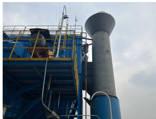
破碎粉尘、粗破筛分粉尘、提升机进料点粉尘、定量给料机进出料点粉尘、制砂机落料点粉尘布袋除尘器+28m 高排气筒 (DA002)
