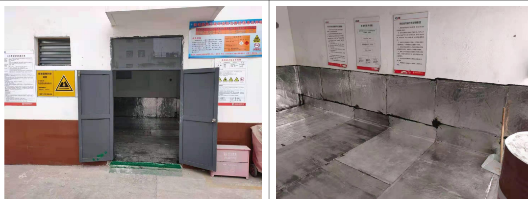
厂区现有危废暂存仓库
