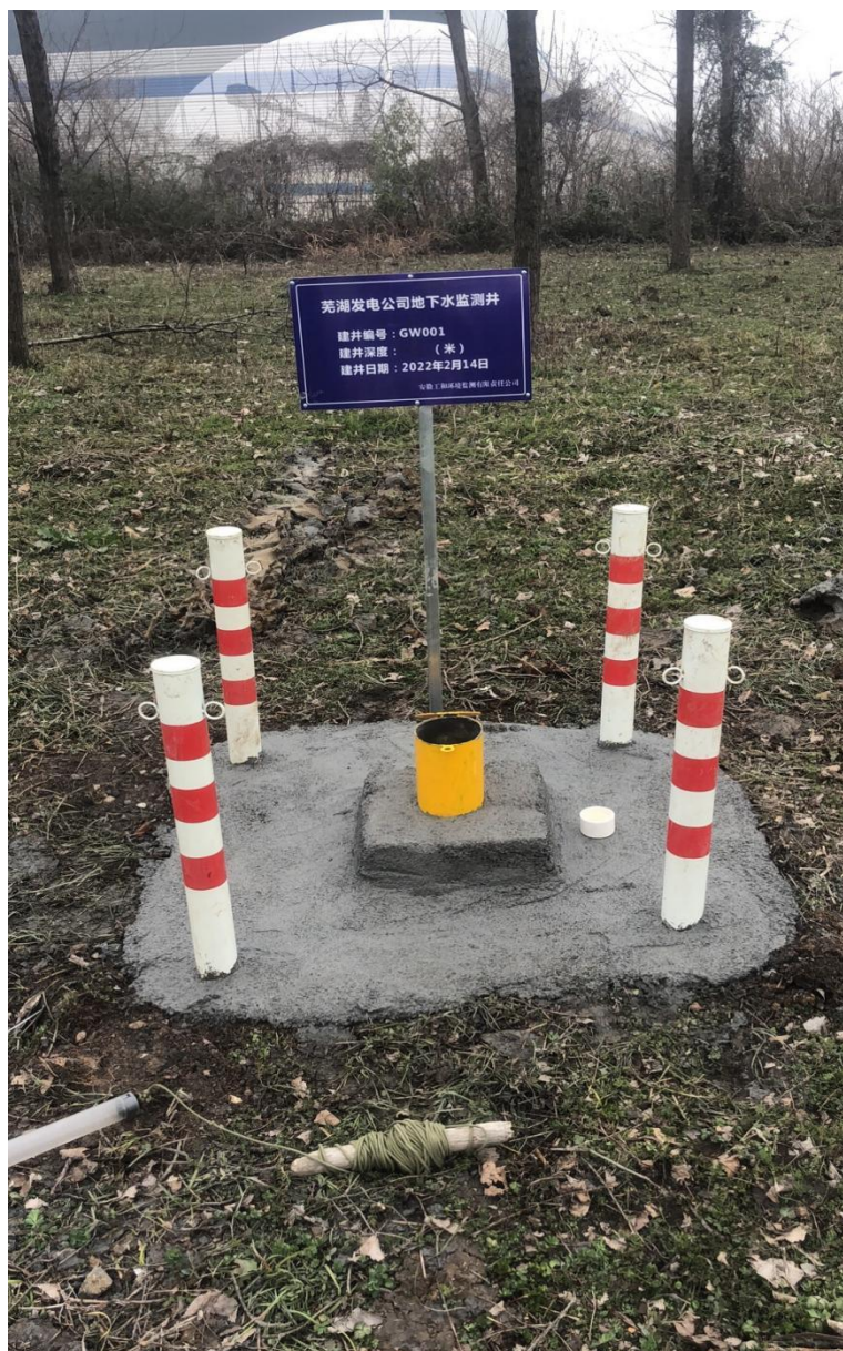
地下水监测井
