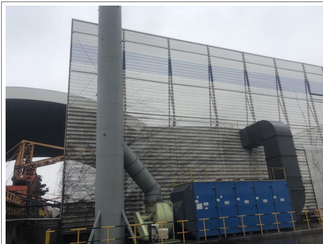
废气恶臭处理设施
