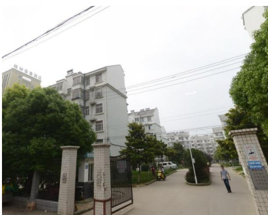
南侧荣风苑小区
