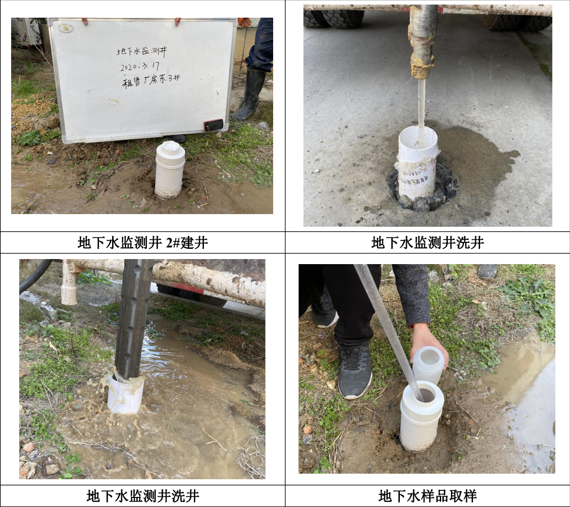
图 5-2 地下水监测井建井、洗井和取样过程
