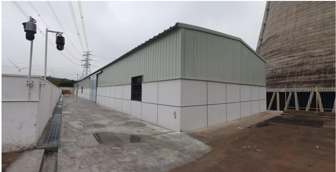
危废库房整体照片
