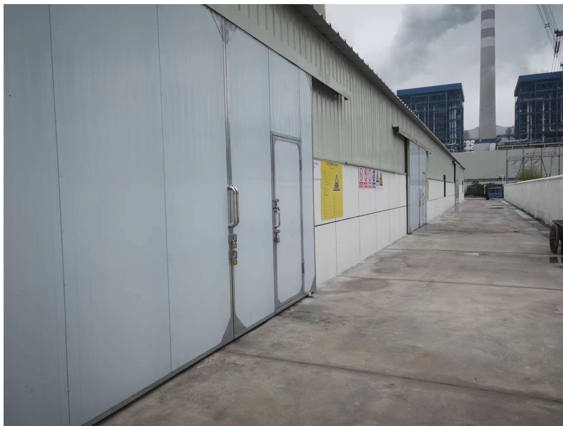
危废库入口和标识牌
