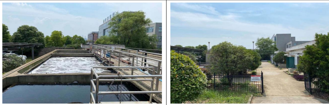
图 3-3 污水处理站现状图
