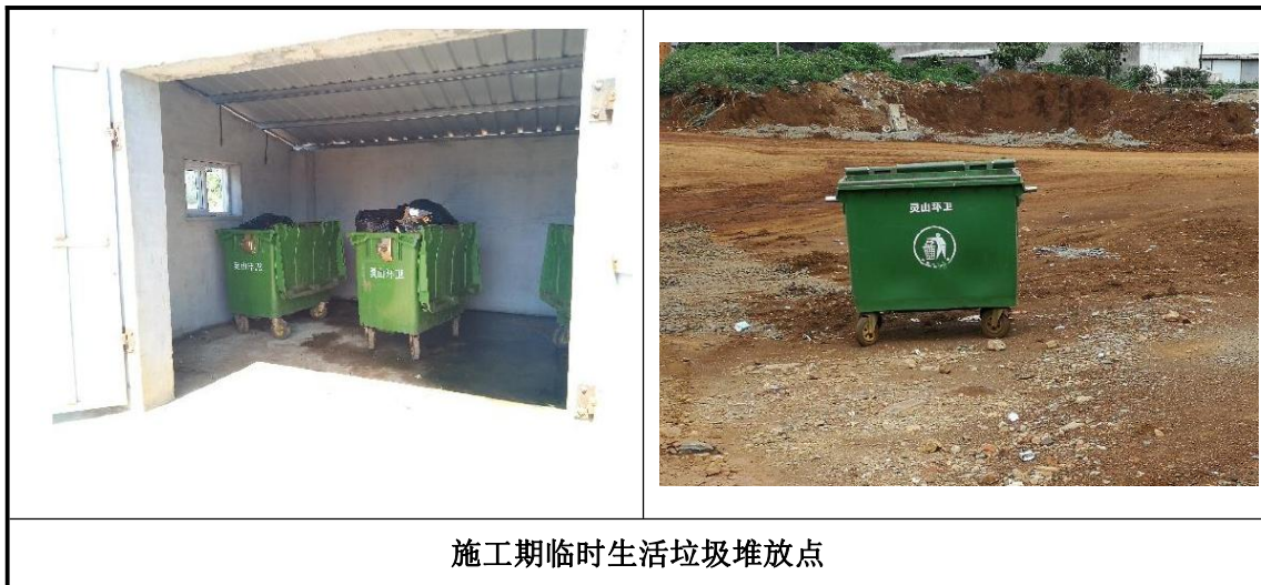
图 4.1-9 本项目施工期固体废物处理设施现场照片
