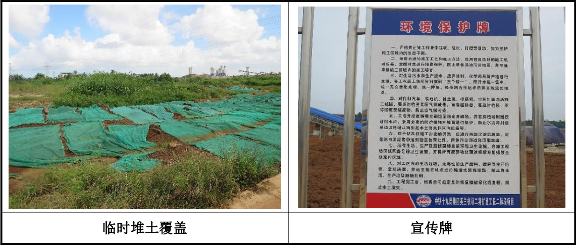
图 4.1-11 施工期生态环境保护措施
