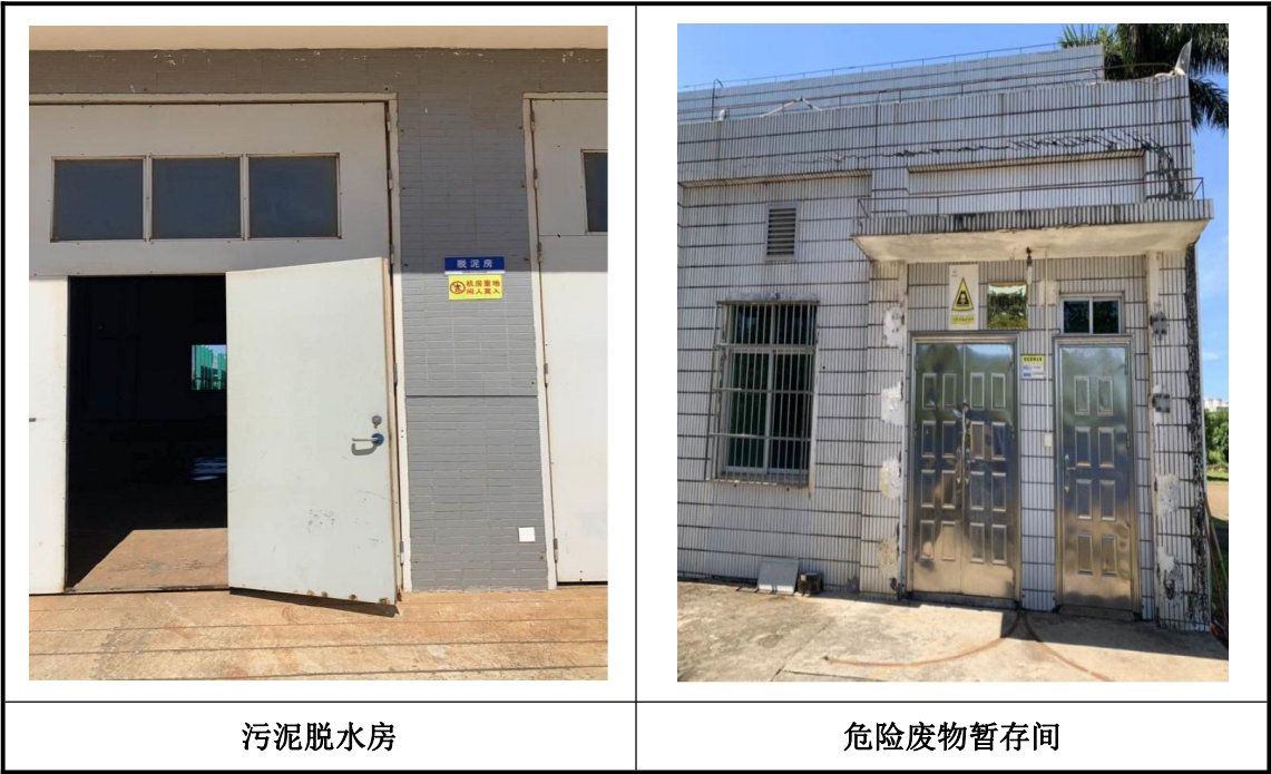
图 4.1-10 本项目固体废物处理设施现场照片
