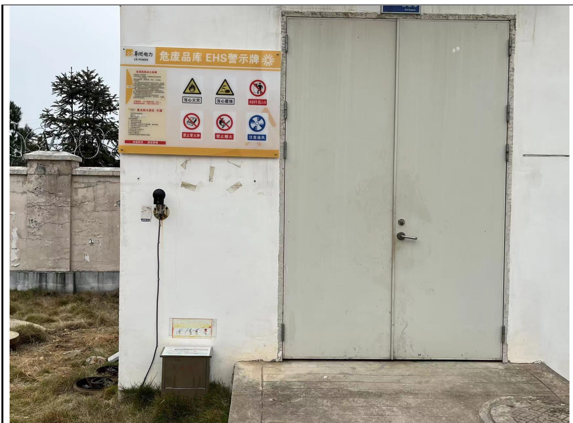
升压站内危废间照片
