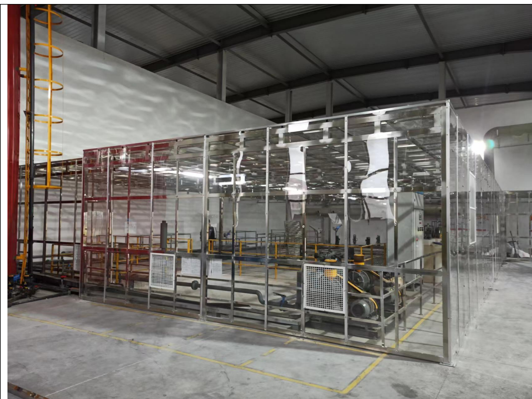
图 3-6 污水站封闭房间
