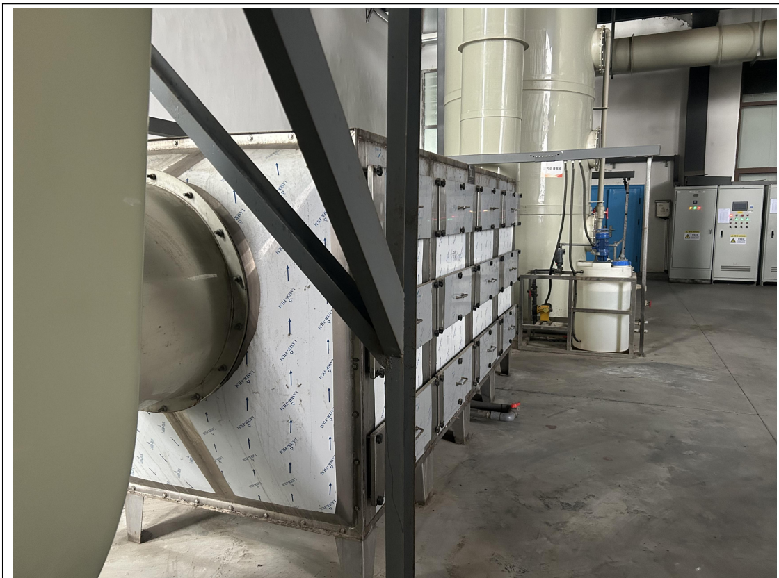
图 3-2 活性炭吸附（注液废气处理）
