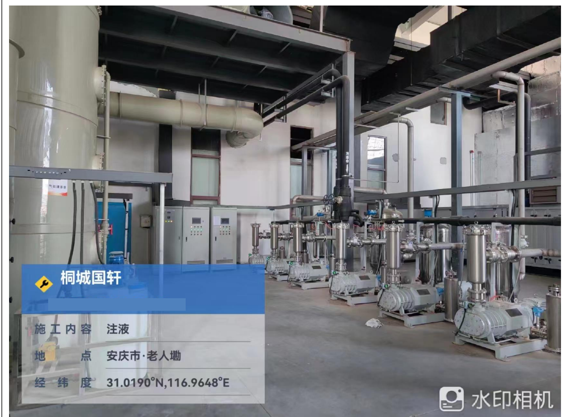
图 3-2 活性炭吸附（注液废气处理）
