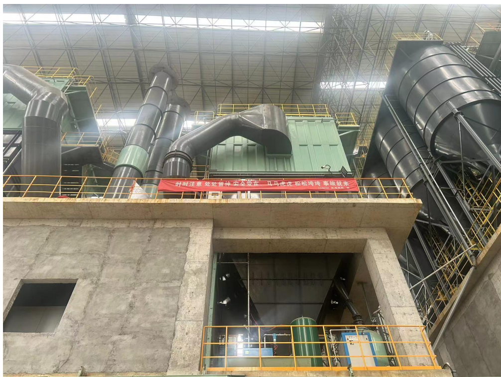
图 3-3 机制砂生产线除尘器（DA001、DA002）
