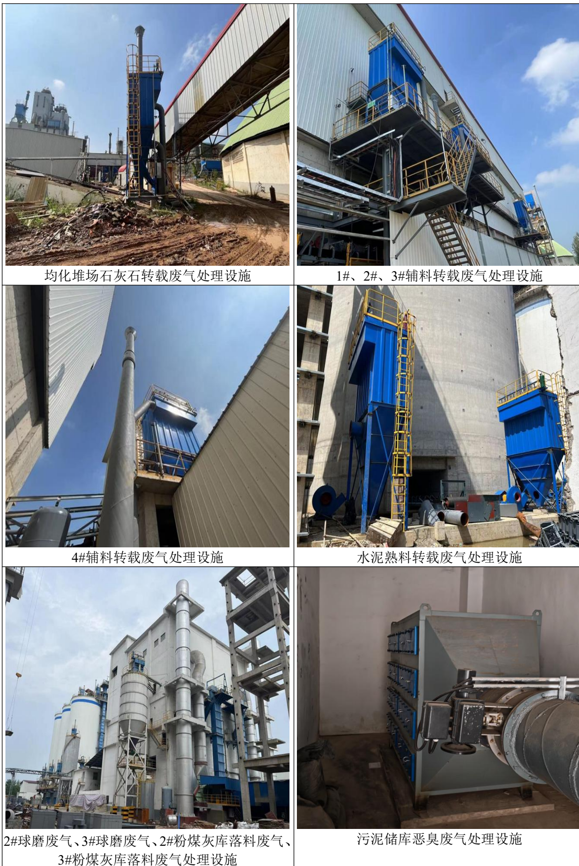
图 4.1-4 部分废气处理设施图片
