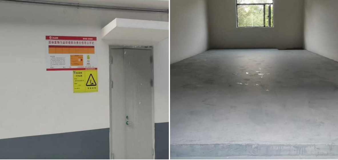
图 4.1-5 危废暂存仓库
