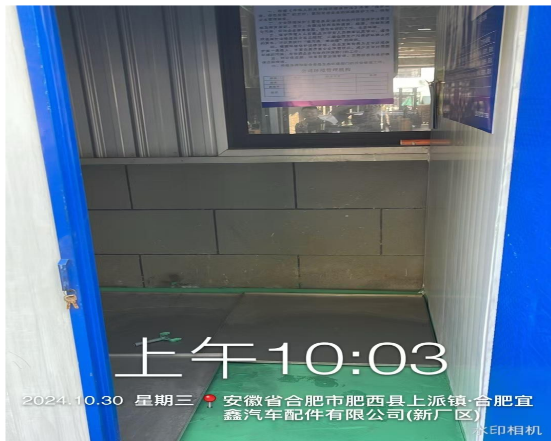
图 3-3 危废间内部照片
