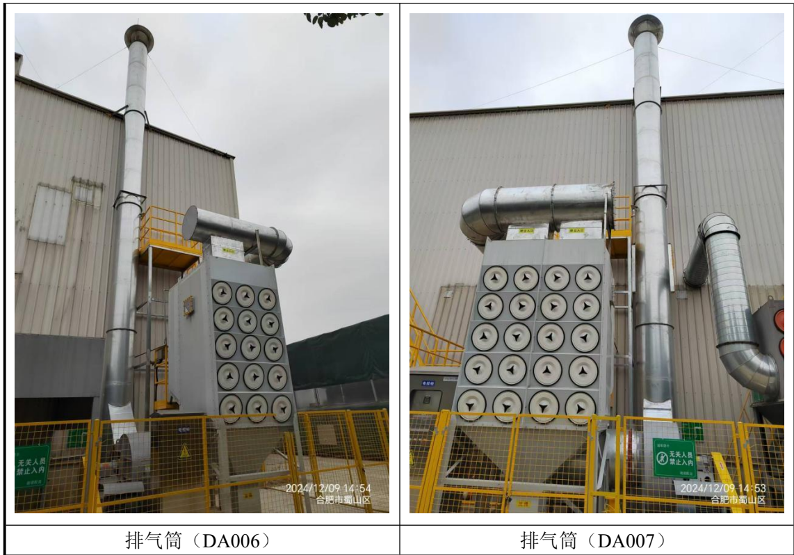
图 4.1-3 排气筒现场照片
