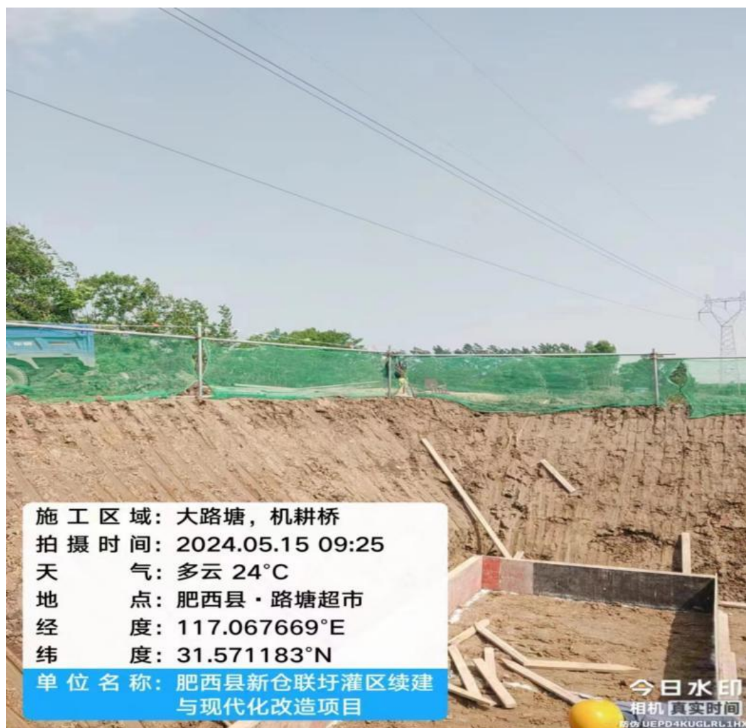
施工现场照片
